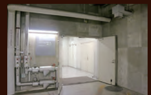
レセプションホール搬入扉 間口1.65m 高さ2m
