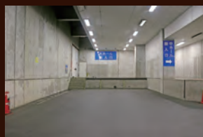
大ホール搬入口 幅7.5m 奥行9.5m 搬入口扉 間口4.3m 高さ3.6m
